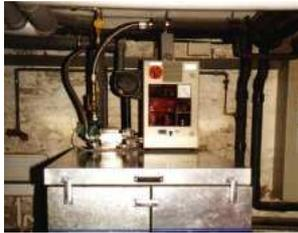
Mit dem Kürzel BHKW wird eine spezielle Form der sog. Kraft-Wärme-Kopplung bezeichnet, nämlich die der dezentralen Wärme- und Stromerzeugung dienende Variante. Heutige BHKW's werden meist mit fossilen Kraftstoffen betrieben, sind also nicht per se der regenerativen Energieerzeugung zuzurechnen. Dies ist nur dann der Fall, wenn zum Betrieb Biokraftstoffe, z.B. Pflanzenöl oder sonstige Biomasse, eingesetzt werden.
