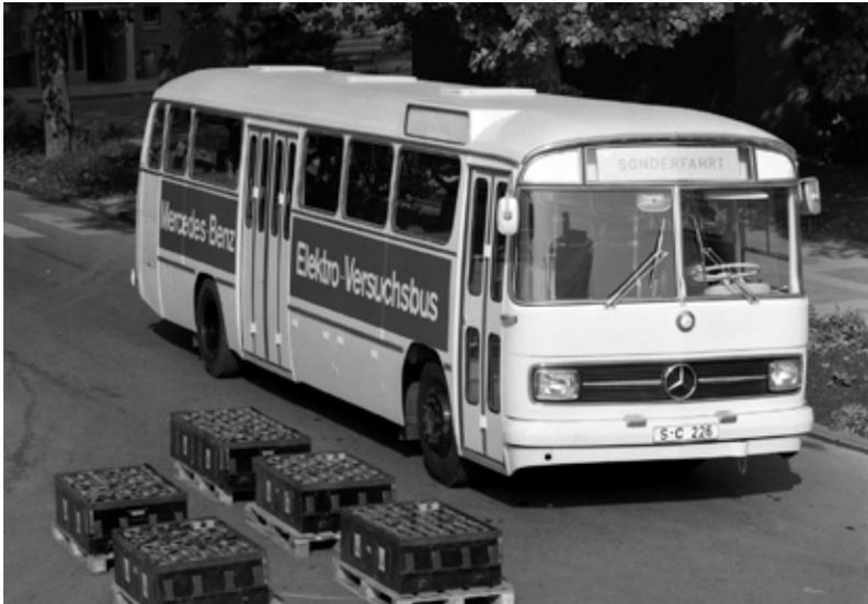
Erst auf der IAA **1969** wird mit dem ‚**OE 302**‘ von Mercedes-Benz **der erste Hybridbus der Welt öffentlich präsentiert**. Der von fünf Batterieb-
